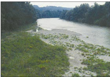
EINGEENGT Die Dämme sind bewachsen und machten so aus der Isar einen Kanal
