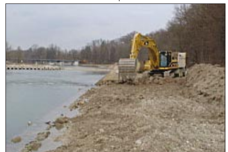
ENTSCHEIDUNG Zur Verbesserung des Hochwasserschutzes bestand die Wahl zwischen Dammerhöhung und Renaturierung
